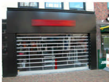
Fout: Afstand tussen palen te groot
