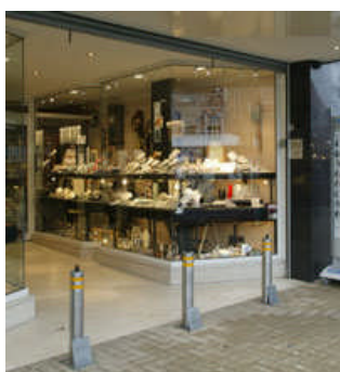
Fout: afstand rolluik/palen = 300 mm
